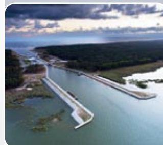
BUDOWA KANAŁU ŻEGLUGOWEGO PRZEZ MIERZĘJĘ WIŚLANĄ
