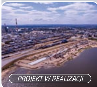
TERMINAL PRZEŁADUNKOWY NA MARTWEJ WIŚLE
